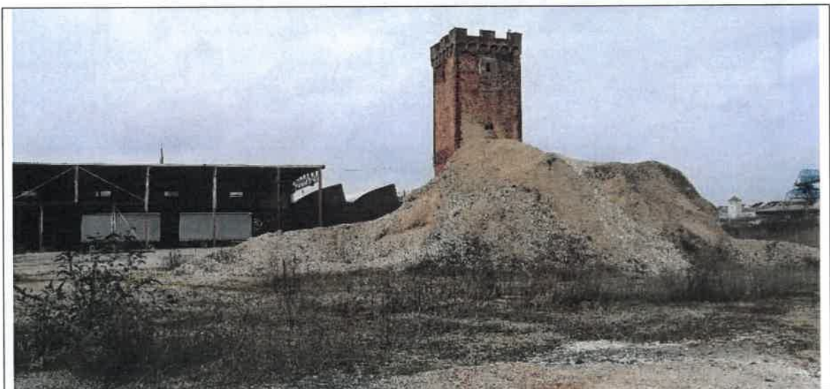
Abb. 15: Haufwerk mit Schlossturm und Lagerhalle im Hintergrund
