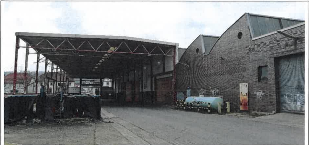
Abb. 16: Ladezone und Lagerhalle
