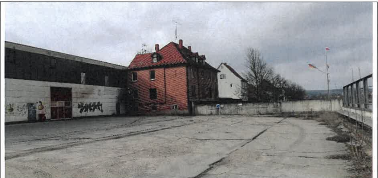
Abb. 17: Rückseite der Lagerhalle mit Betonfläche
