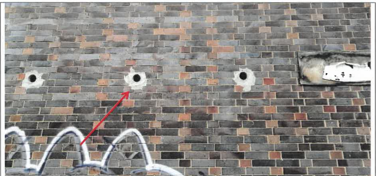
Abb. 18: Lüftungsöffnungen der Lagerhalle
