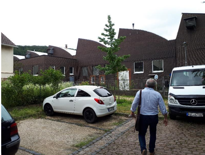
Die Sheddach Halle zur Stadt – eigene Aufnahme
