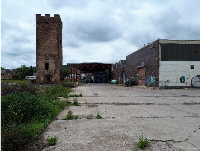
Die Sheddach Halle beim Turm mit dem Vordach
