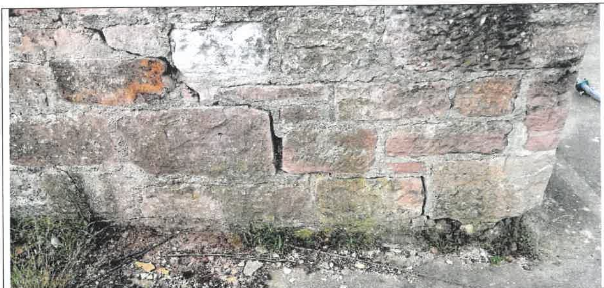
Abb. 23: Verfugter Sandsteinsockel mit einzelnen offenen Spalten
