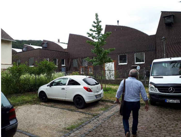
Die Sheddach Halle zur Stadt – eigene Aufnahme
