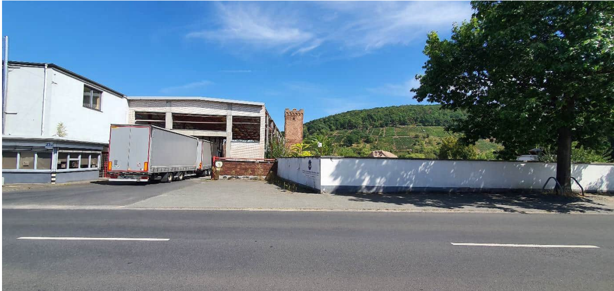
Aktuelle Eingangssituation von der Landstraße, eigene Aufnahme
